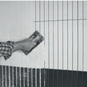
3. Colocación del mortero de junta con los materiales recomendados.
