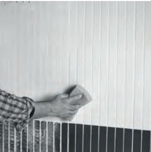
4. Limpieza del mortero sobrante.
